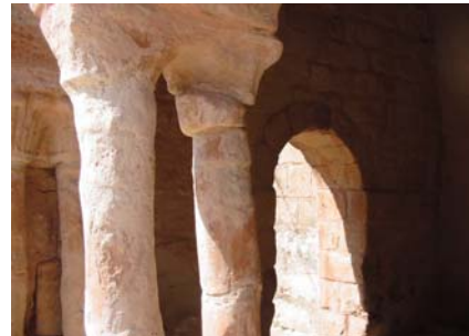
Detalle de las columnas de la iglesia de Cubillas
