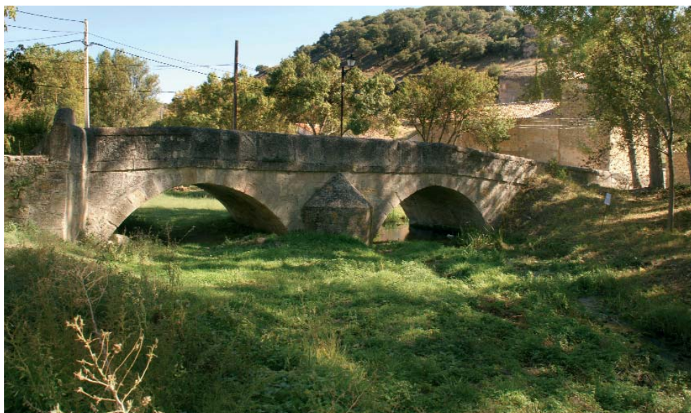
Puente de La Cabrera
