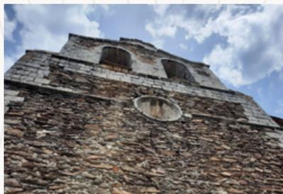
**Figura 7-3** Detalle de uno de los muros de la iglesia, donde se aprecia el diferente uso y forma de los bloques de caliza y de gneis.
