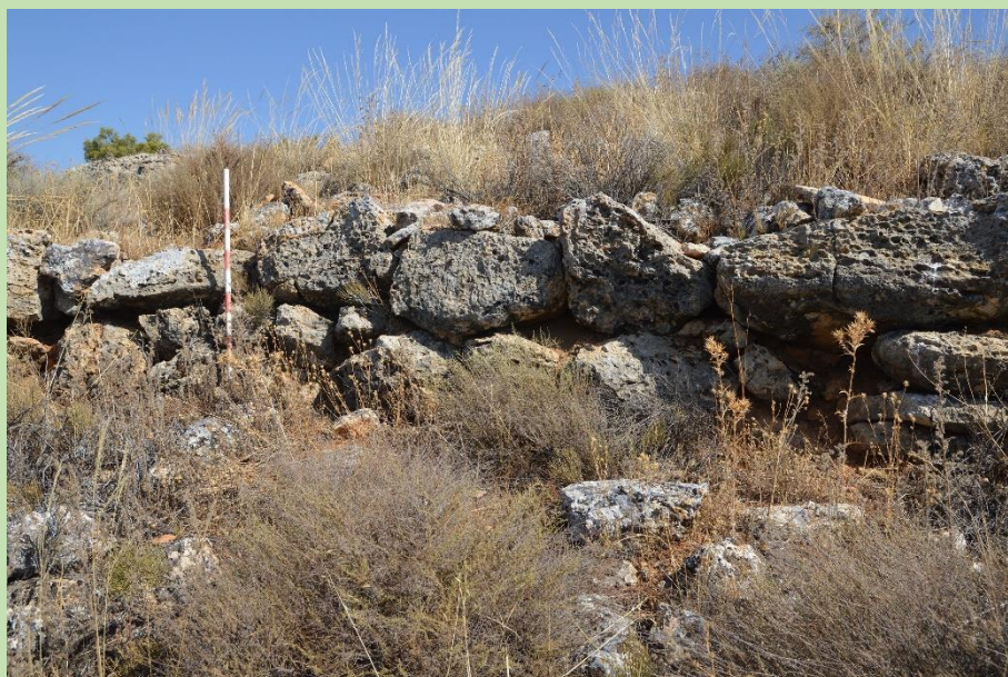
Muro perimetral con grandes bloques en el poblado de tipo morra de la Huerta de Aguas (Argamasilla de Alba, Ciudad Real)
